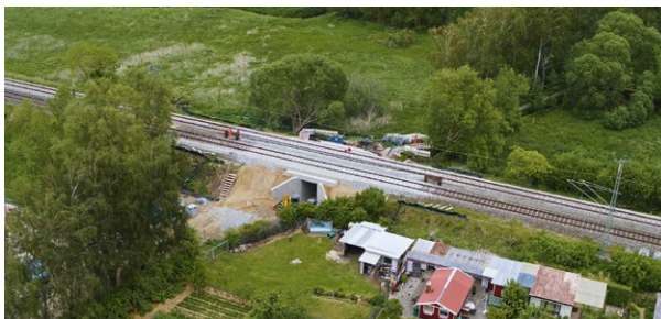
Streckenertüchtigung Nordbahn (Nordabschnitt) Abschnitt Demmin – Stralsund
