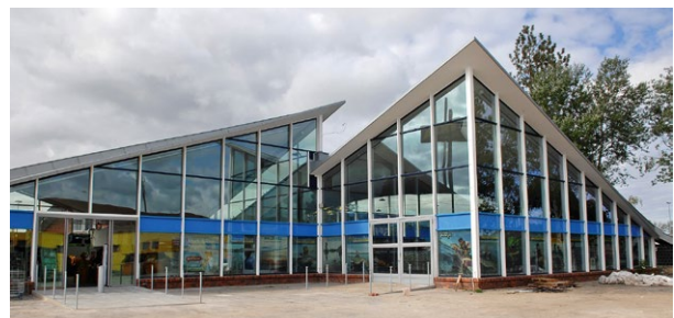
Nutzungsänderung ehem. Messehalle/Ausstellungspavillon in Einzelhandel + energetische Sanierung Einzeldenkmal in Rostock
